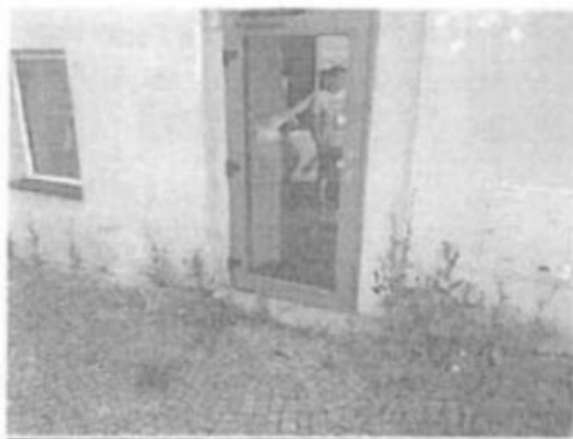
Obr.7: Narušené zdivo domu Mariánské údolí č.p.106
