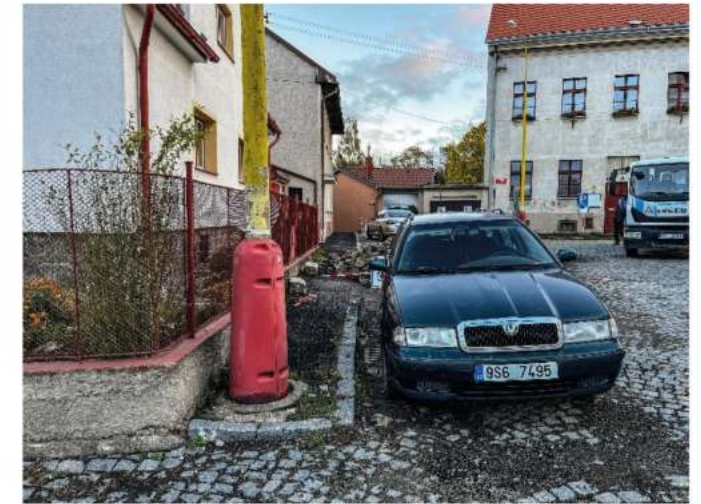
Obr. 16 Chodníky nespĺňující základní normové parametry, špatný stavebně technický stav.
