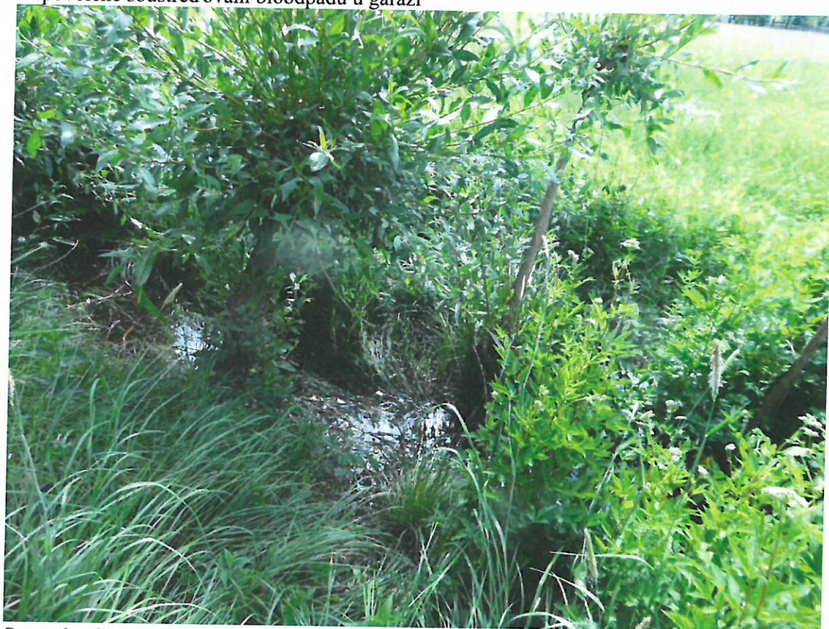
Stav odvodňovacích struh
